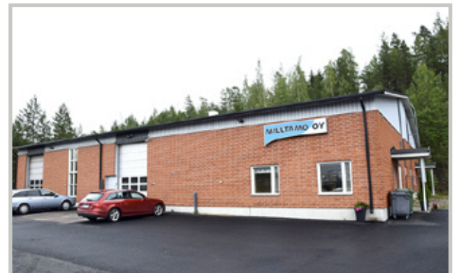
Milltamo aloitti vuonna 1987. Nykyiset 820 neliömetrin tuotantotilansa yritys rakennutti Ylöjärven Soppeenmäkeen vuosituhanen vaihteessa.
