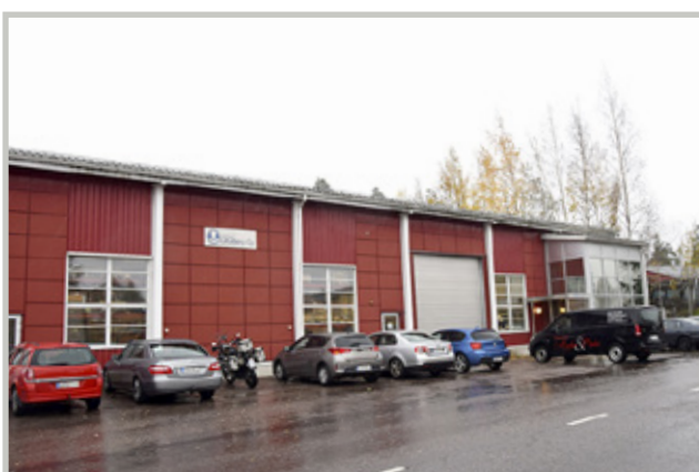
Uudenmaan Ohutlevy toimii Keravan Myllynummen alueella nykyaikaisissa vuonna 2011 laajennetuissa tiloissa.
