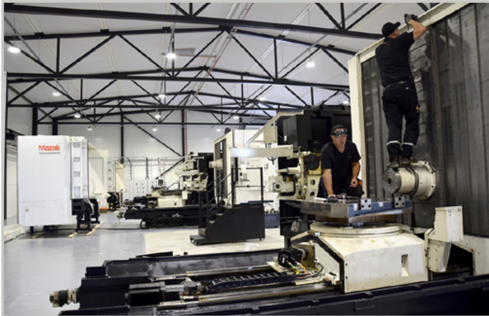
Asennustyöt käynnissä. Kolmen kookkaan vaakakaraisten koneistuskeskuksen automaatiojärjestelmä on kokoluokaltaan ainutlaatuinen koko Euroopan mittakaavassa.
