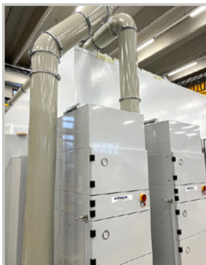
Dormatecin ilmansuodatinlaitteistossa on useita suodattimia, joiden vaihtotarpeen voi havaita hyvin näkyvillä olevista painemittareista. Putkistot ovat järeitä ja kovaa käyttöä kestäviä. Jäähdytysnesteelle on oma liikuteltava suodatinlaitteistonsa, johon on rakennettu riittävä kapasiteetti palvelemaan juuri kyseistä projektia.
