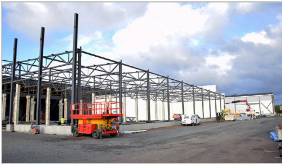
Uusi kookas tilalaajennus. Uuden 7800 neliömetrin hallin rakennustyöt olivat käynnissä marraskuulla.
