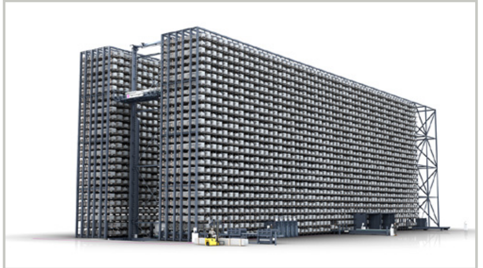
Automaatio parantaa myös työturvallisuutta. Kun varastoautomaatiikka hoitaa tuotteiden siirron ja keräilyn varistorakenteiden suojissa, trukkien ja työntekijöiden tarvitse liikkuu samoilla väylillä.
