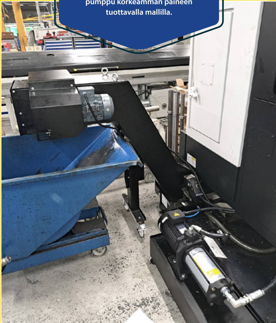
19,5 bar upgradesetti asennettuna
